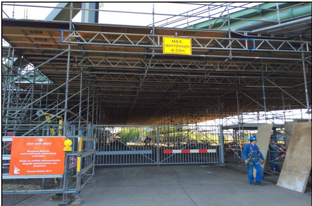
Foto: de aangebrachte steigers zorgen ervoor dat de onderzijde van de brug goed en veilig bereikbaar is
