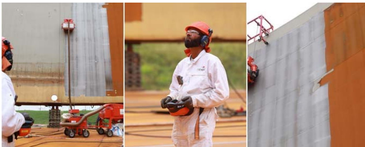
Machinestrallen tankwand inwendig, BPRR
