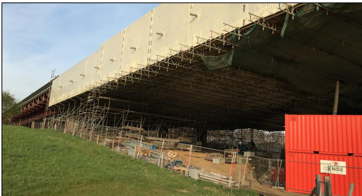
Foto: Het derde deel van de Scharbergbrug wordt momenteel onder handen genomen.
