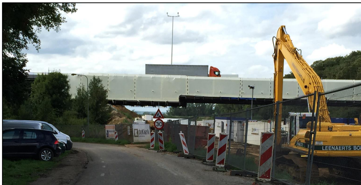
Foto: afschermende maatregelen voor de conserveringswerkzaamheden boven het Julianakanaal
