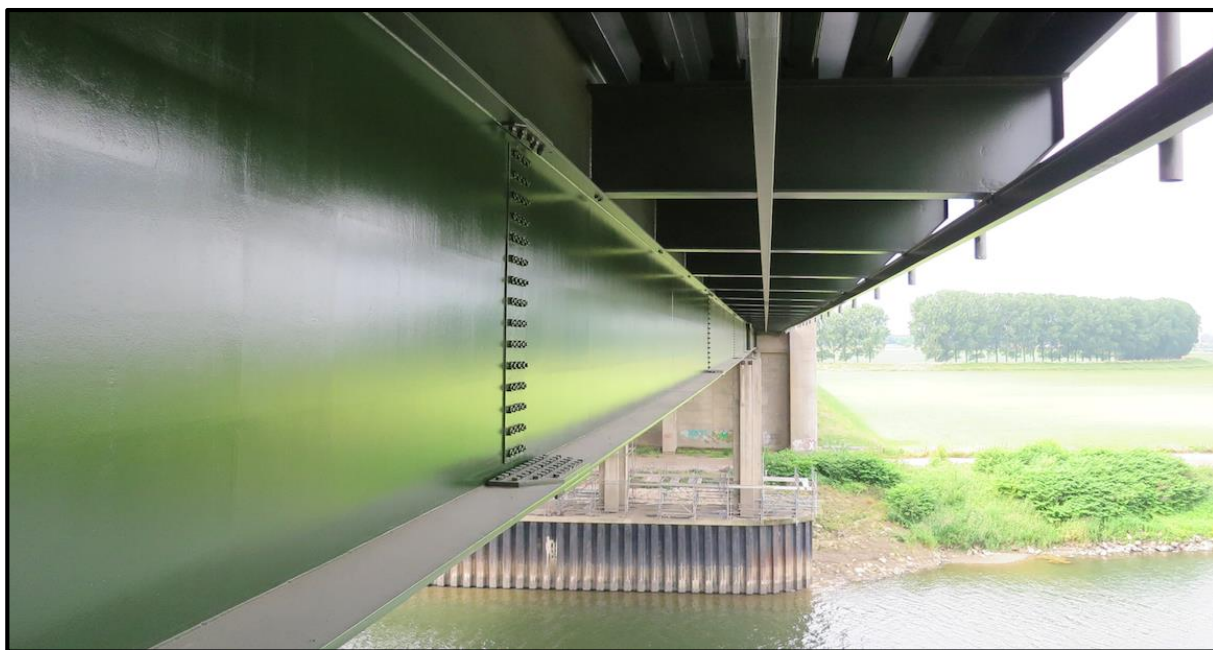
Foto: De eerste 200 meter van de Scharbergbrug staat in de nieuwe verf.
