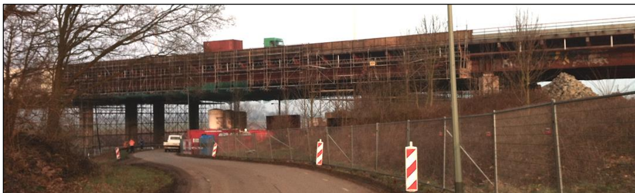
Foto: Het derde deel van de Scharbergbrug staat in de steigers
