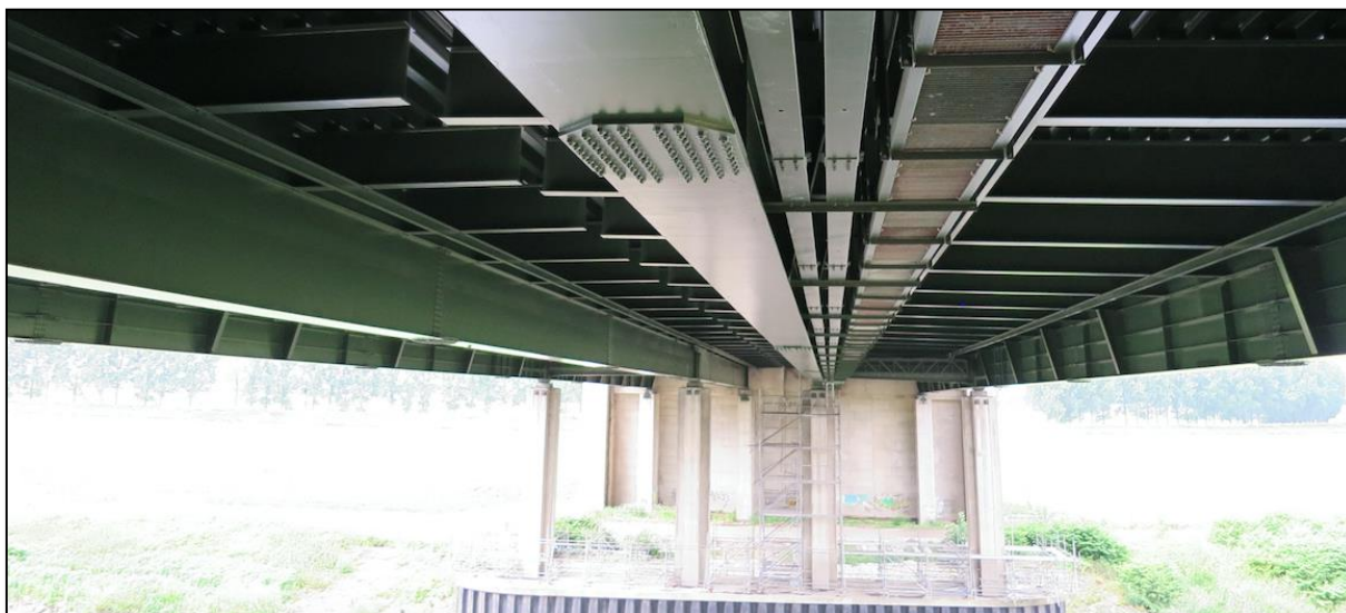
Foto: De onderkant van de brug zit weer strak in de verf
