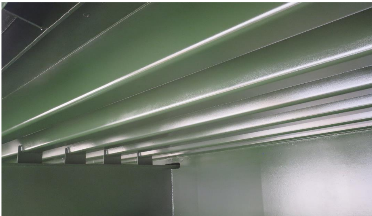
Foto: Alweer 40 meter van de brug staat in de nieuwe verf. In totaal is nu zo'n 230 meter geconserveerd.
