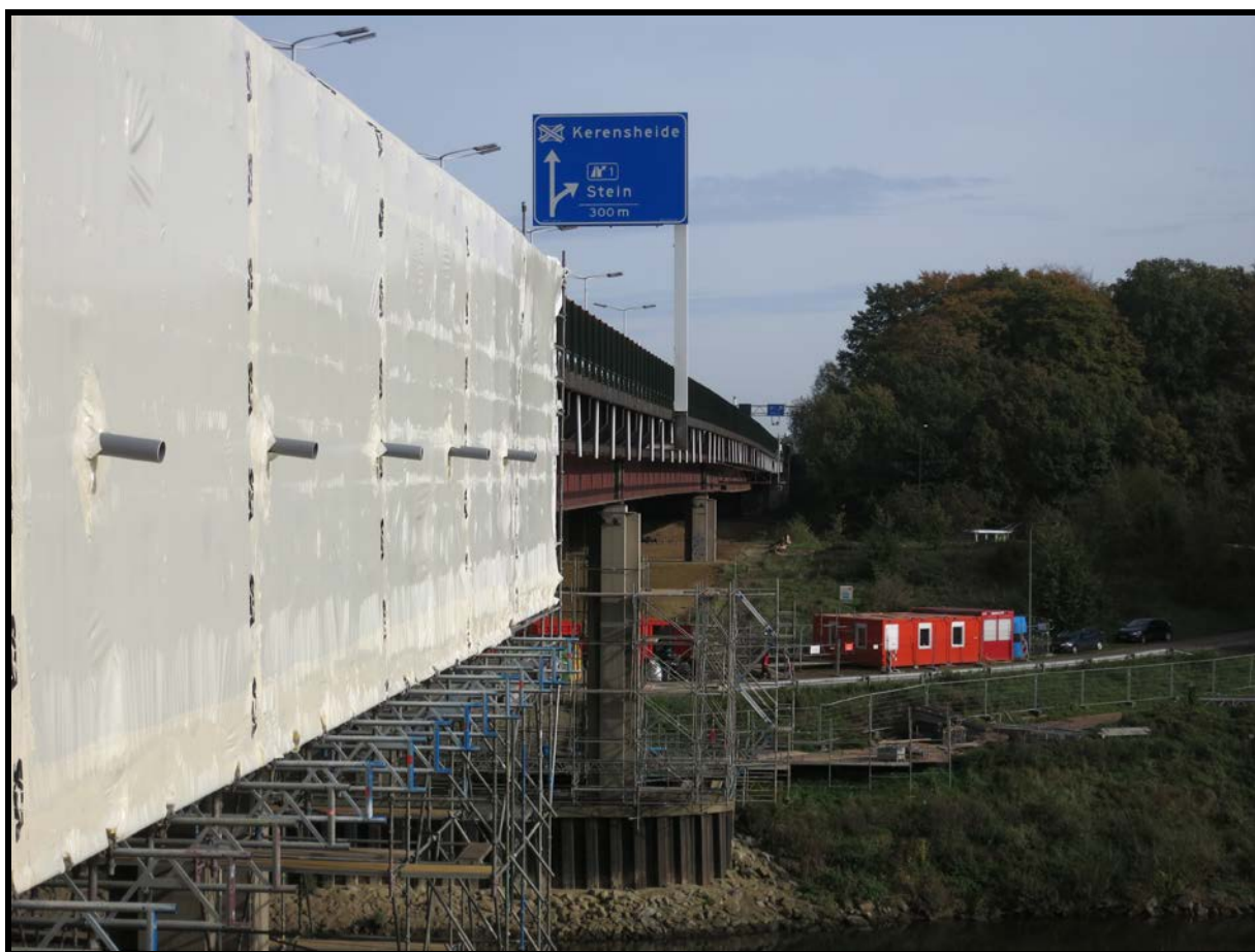
Foto: op de voorgrond de ingepakte steigers, op de achtergrond de werkplaats
